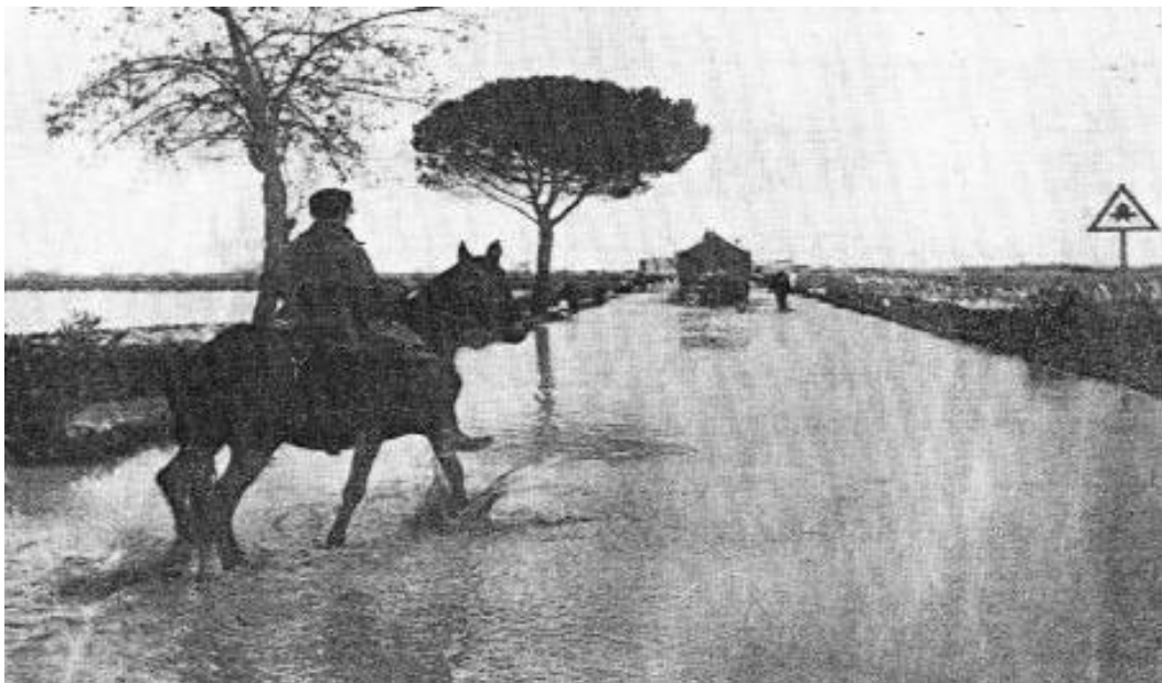
Figura 5: SS 106 invasa dall'acqua a seguito dell'esondazione del fiume Basento (da "Basilicata" del 29/11/59).
