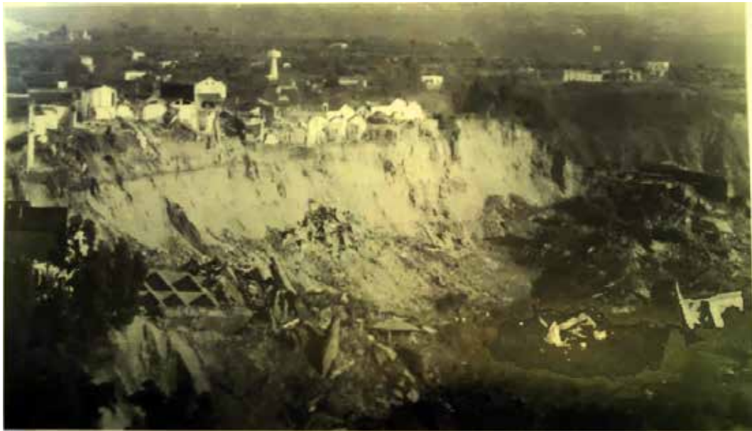
Figura 6: Frana Pisticci 1976, Rione Croci, in località Patorosso.
