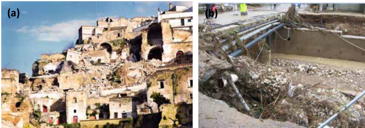
Figura 9: a) Crollo abitazioni nel Comune di Ginosa; b) Ponte danneggiato sulla strada SP 1 per Montescaglioso.
